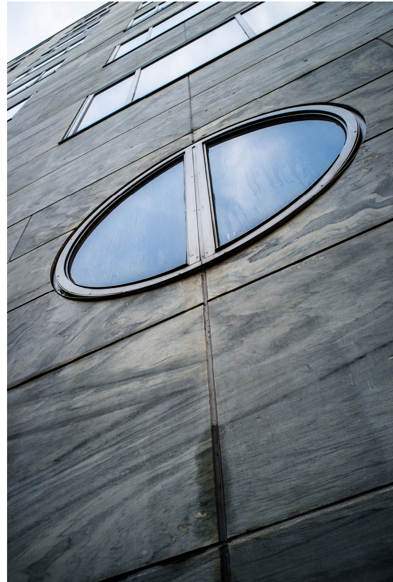
Particolare della facciata della sede della Montecatini, Gio Ponti, Milano, Via Turati.
