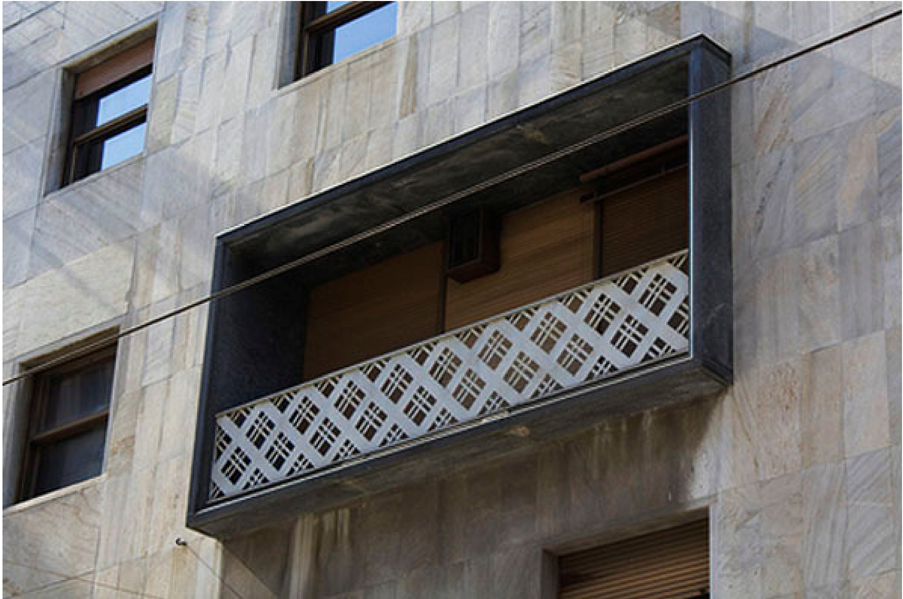
Particolare della facciata della sede della Ras (1956-1962), Milano.
